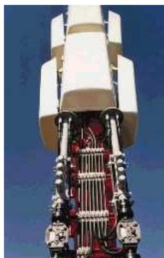
Rys.3. Antena nadawcza TV firmy Kathrein (4 x 2 piętra).
